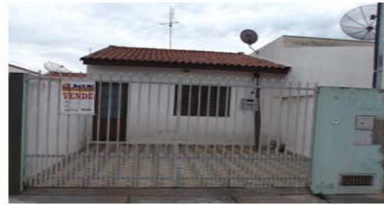
01 Sala, cozinha, wc, lavanderia garagem para 02 carros.....(REF: NC256)
