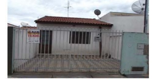
01 Sala, cozinha, wc,lavanderia garagem para 02 carros.....(REF:NC256)
